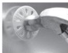
Poser une cheville d'isolation. L'isolation est maintenant fixée et résiste au vent.
