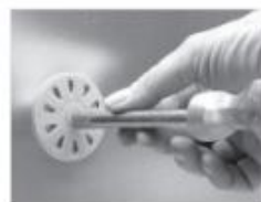
Encastrer l'ancrage à l'aide d'une douille adaptée jusqu'à la cheville.
